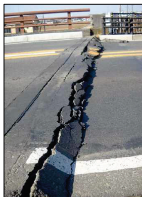
破損した道路面がスロープ状に残っている段差 (H23東日本大震災/茨城県内)
