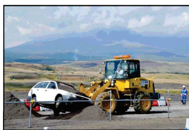
写真：中部地方整備局の防災訓練 (平成26年10月)
