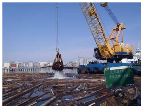
図 5-3 石巻港における浮遊物の囲い込み（左）及び浮遊物揚収（右）の実施例 18)
