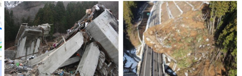
津波による橋梁流出
