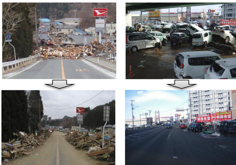
図2 道路啓開（上：被災直後 下：道路啓開作業後）
