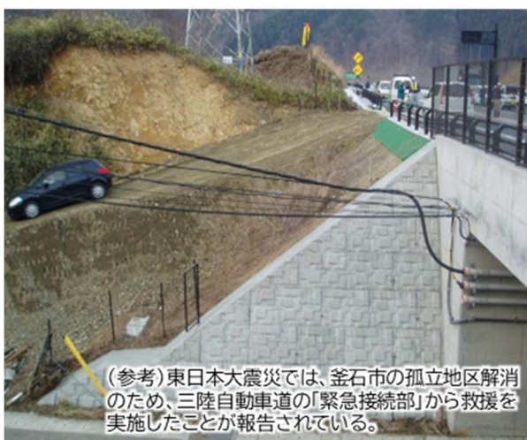
図 3-2 緊急接続部イメージ (三陸自動車道)
