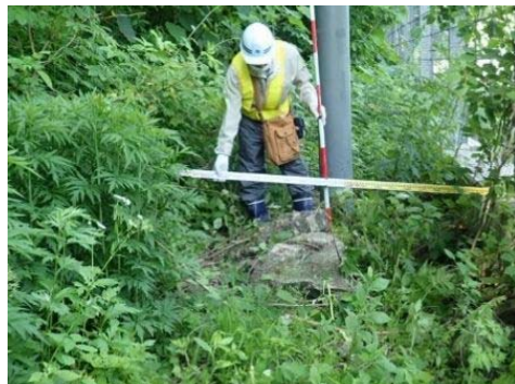
防護柵背面の落石状況近景 R3.6撮影
