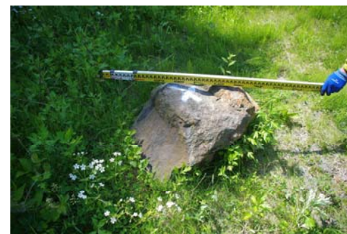
土堤背面の落石状況 R3.6撮影
