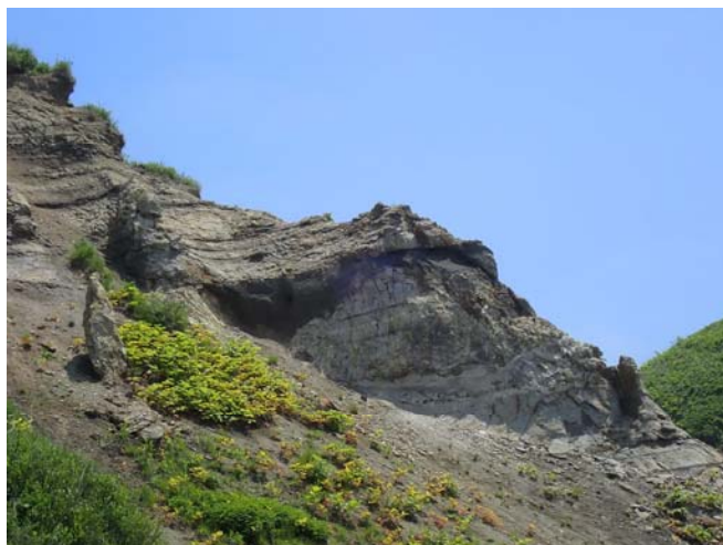
正面全景R3.6撮影 ※塔状岩体の崩落跡
