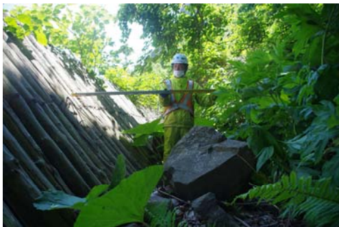
防護柵背面の落石状況 R3.6撮影
