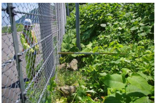
防護柵背面の落石状況 R3.6撮影
