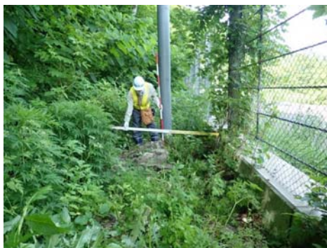
防護柵背面の落石状況 R3.6撮影
