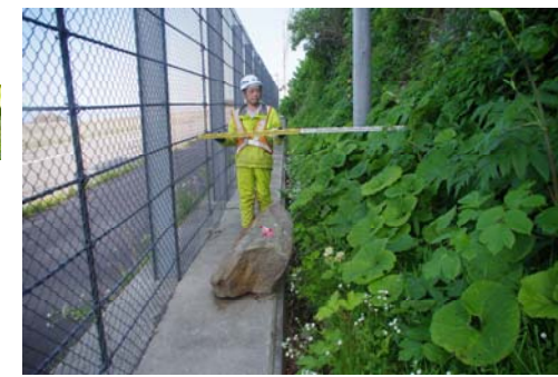
防護柵背面の落石状況 R3.6撮影
