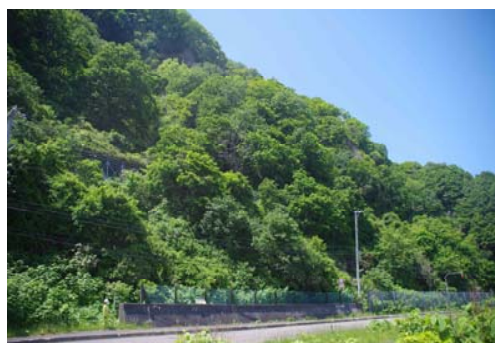
中間部全景R3.6撮影
