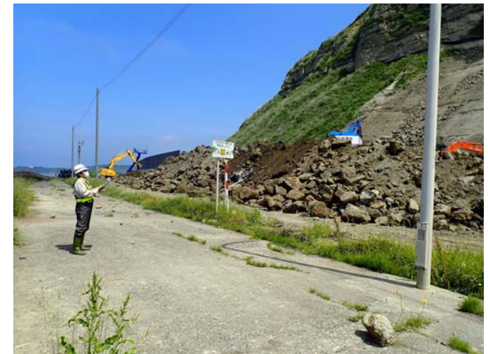
緊急点検実施状況
