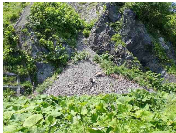
崩壊岩塊の堆積状況 R3.6撮影
