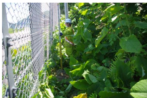
防護柵背面の落石状況 R3.6撮影
