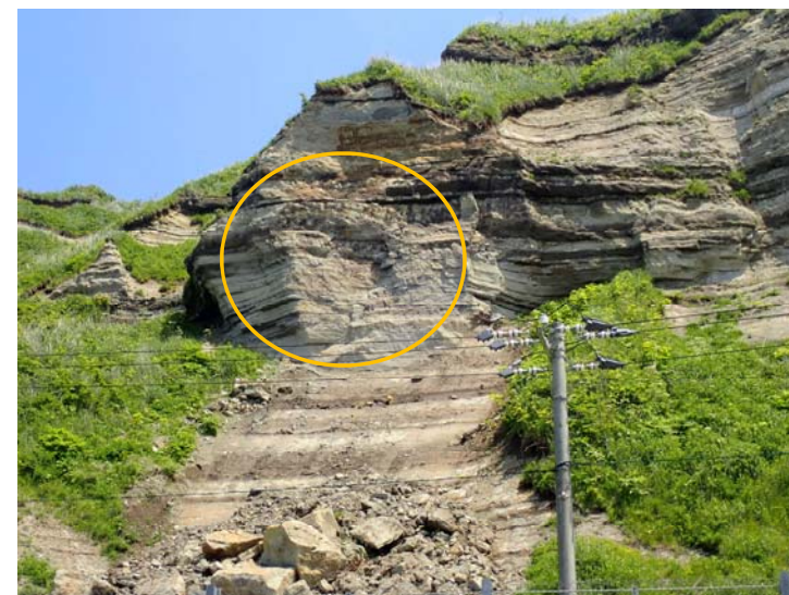
正面全景R3.6撮影 ※岩盤崩落跡
