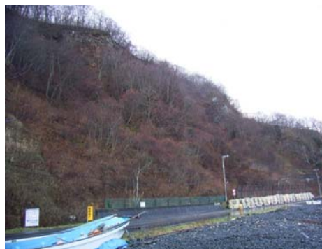
中間部全景H19撮影
