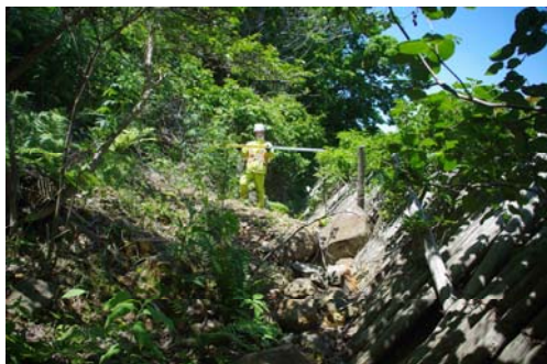
防護柵中間部の落石状況 R3.6撮影
