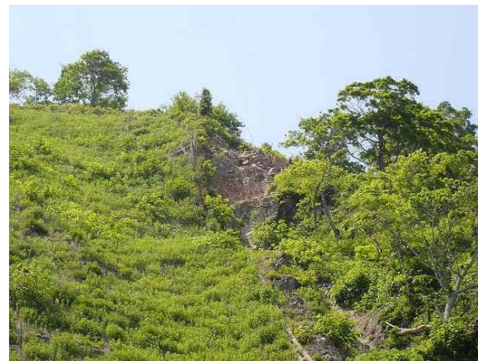
法枠工脇の崩壊跡近景 R3.6撮影
