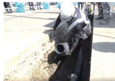
▲角型多条電線管敷設の状況 (R3.9.2)
