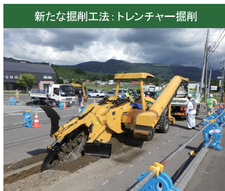
▲トレンチャー掘削の状況 (R3.9.2)
