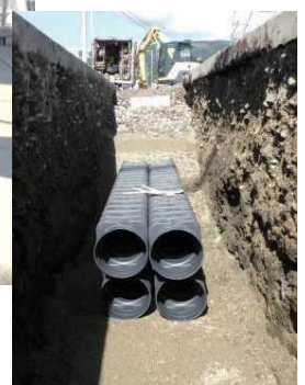
▲施工断面の状況 (R3.9.2)
