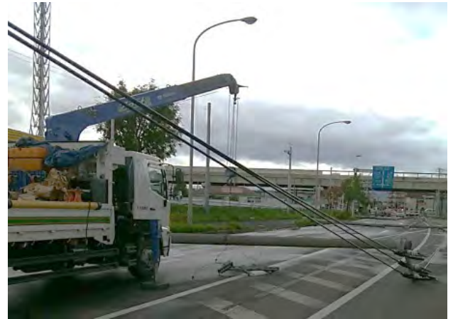
▲台風による電柱の倒壊 (H30.9 札幌市 国道275号)
