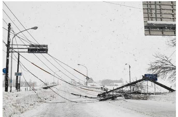
▲暴風雪による電柱の倒壊 (R4.12 幕別町 国道38号)
