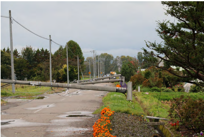
▲突風・飛来物による電柱の倒壊 (R3.10 東川町 町道西9号線)
