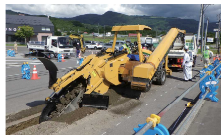
▲高速掘削が可能なトレンチャー
