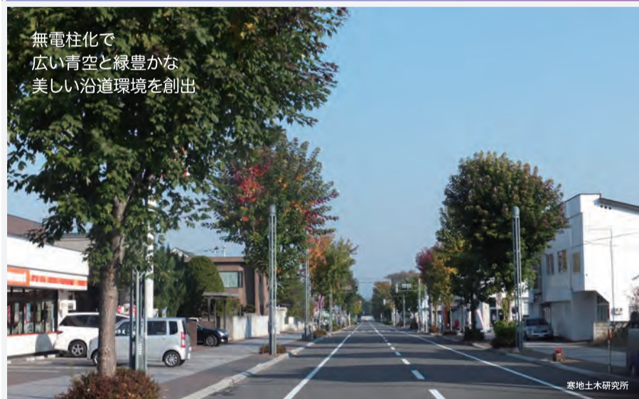
43 裏配線方式 芽室町 / 本通(豊頃糠内芽室線)
