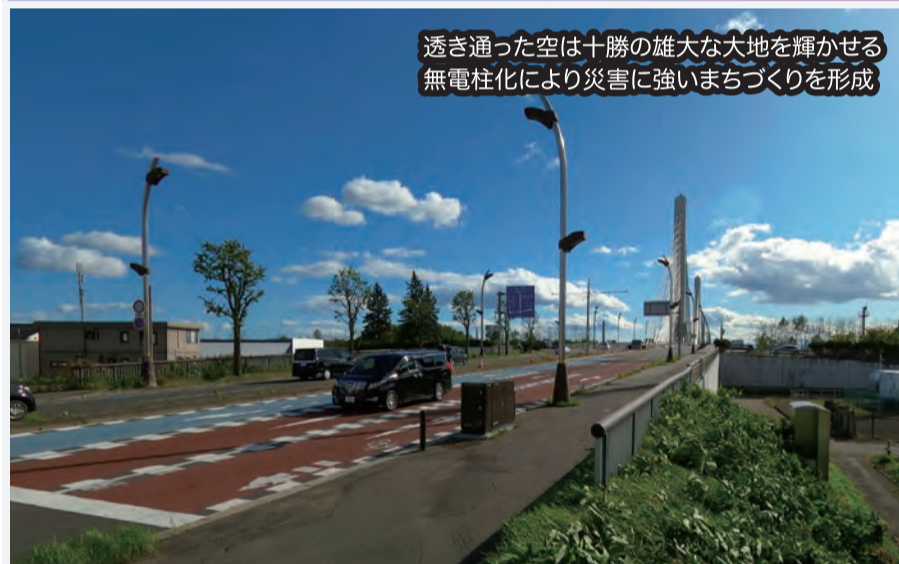
42 地中化方式 音更町 / 音更大通(国道241号)
