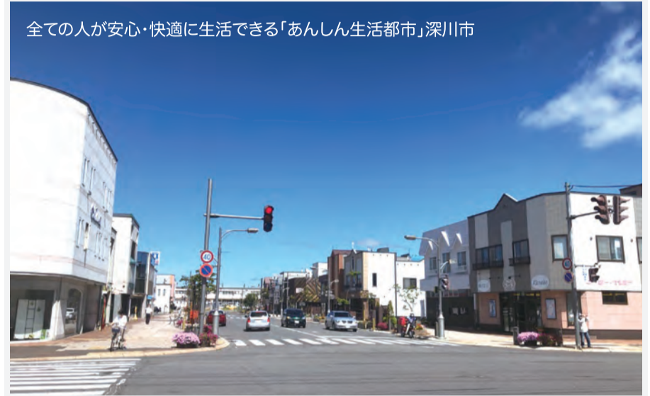
12 地中化方式 深川市 / 深川駅前通(深川停車場線)
