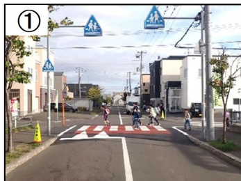
R3可搬型ハンプ試験設置
