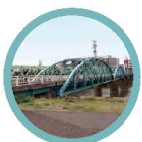
福島県 松島橋 1925年架設 橋齢98年
