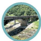
鳥取県 若桜橋 1934年架設 橋齢89年
