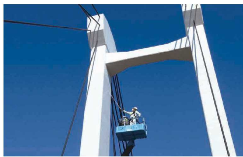
一本杉橋（斜張橋）の主塔部の高所作業車を用いた近接目視点検の状況。特殊構造の橋梁も管理しているため、橋梁の特性を踏まえた点検ができるよう事前の意見交換が重要であった。
