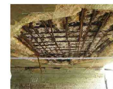
床版鉄筋露出：橋を通行する自動車などの荷重を直接支持し主桁に伝達する部材の鉄筋が露出している状態
