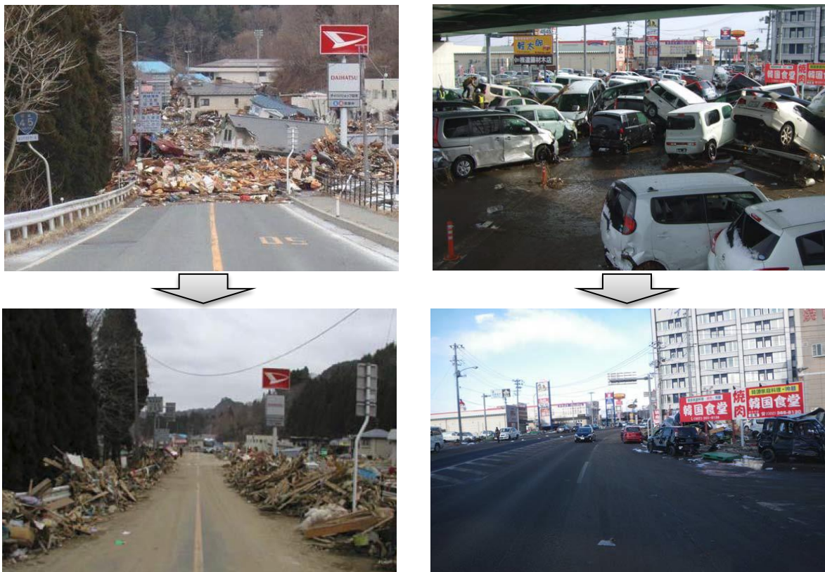
図 9 道路啓開（上：被災直後 下：道路啓開作業後） 10), 11)
