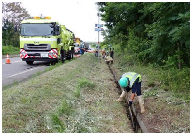
【排水構造物清掃】
