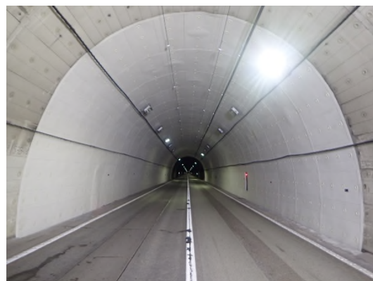
【道路トンネル補修後】
