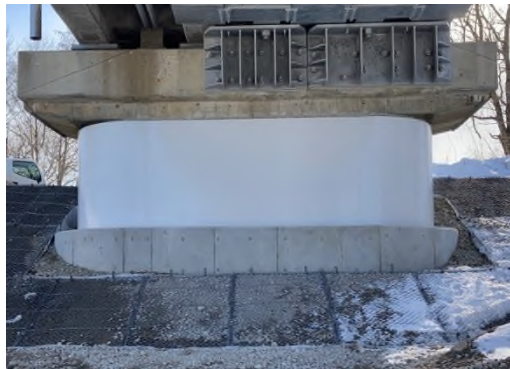
【耐震補強（下部工補強）】
