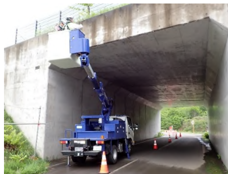
【大型カルバート点検】
