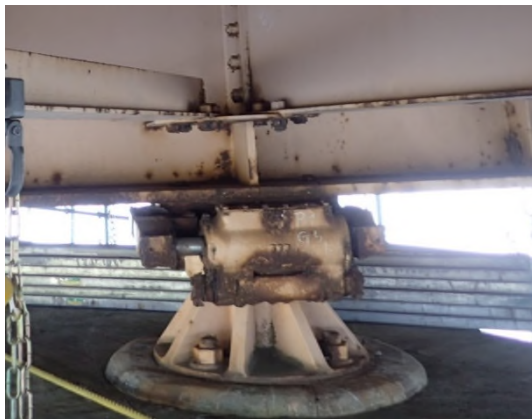
【橋梁補修前（支承）】
