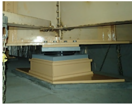
【橋梁補修後（支承）】
