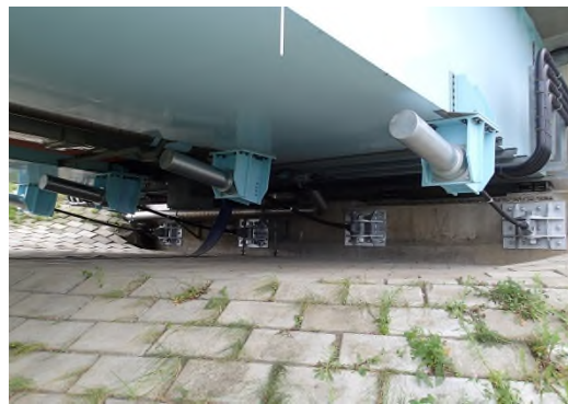
【耐震補強（落橋防止工）】
