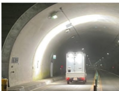
画像計測技術による覆工撮影
