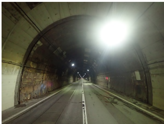
【道路トンネル補修前】
