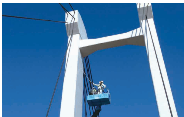
一本杉橋（斜張橋）の主塔部の高所作業車を用いた近接目視点検の様子。特殊構造の橋梁も管理しているため、橋梁の特性を踏まえた点検ができるよう事前の意見交換が重要であった。
