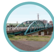
福島県 松齢橋 1925年架設 橋齢98年
