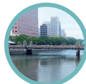
広島市 京橋 1927年架設 橋齢96年
