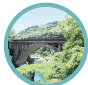
宮崎県 網之瀬橋 1926年架設 橋齢97年
