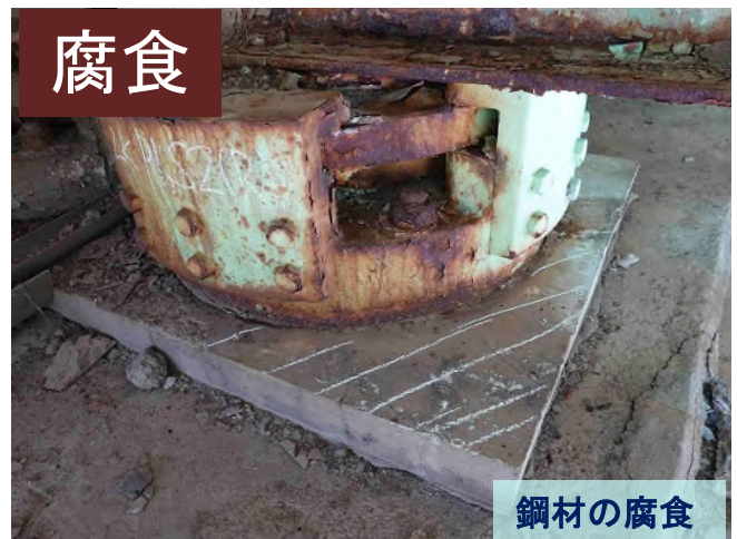
鋼材の腐食
