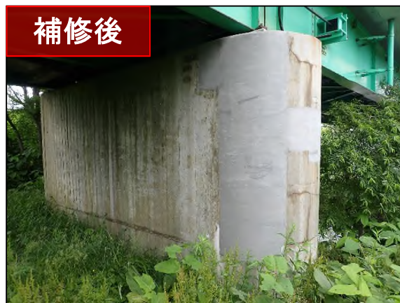
橋脚の補修(断面修復)
