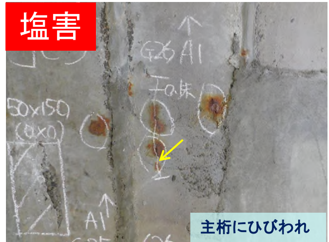
鋼材腐食による錆汁
