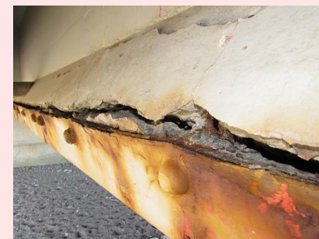
塩害による損傷が進行し、危険な状況に
