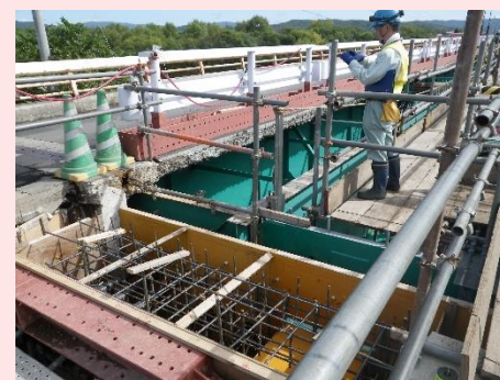
交通規制による「床版取替え」
