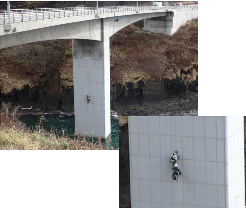
従来点検 (ロープアクセスによる近接目視)
