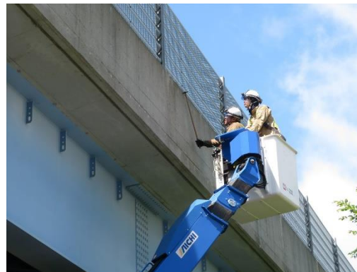
高所作業車による点検
