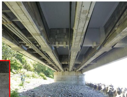
断面修復、電気防食による補修
