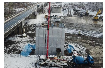
架替工事を実施
