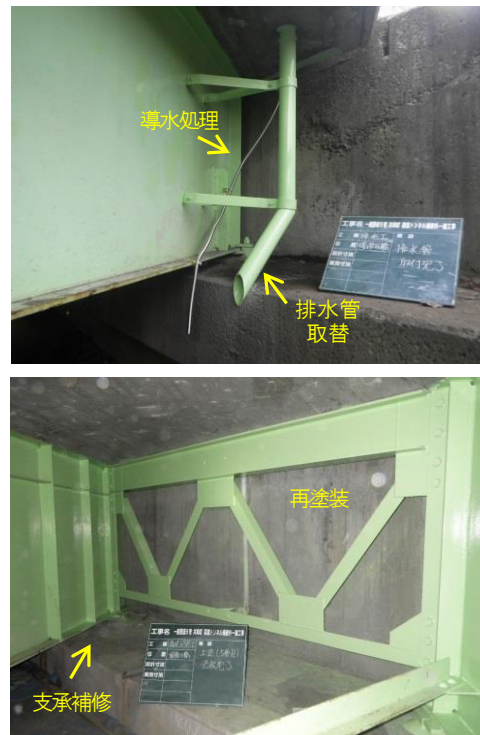
伸縮装置、排水管の止水処理 桁端部部分塗装、支承補修
