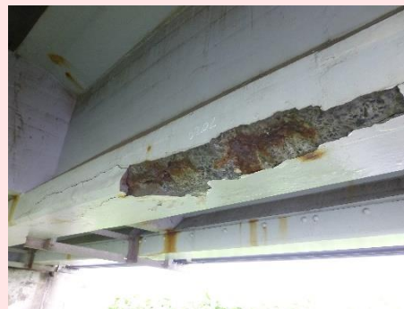
塩害による損傷が進行し、危険な状況に
