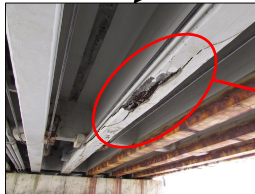
飛来塩分による塩害の損傷
