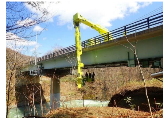
橋梁点検車による点検
