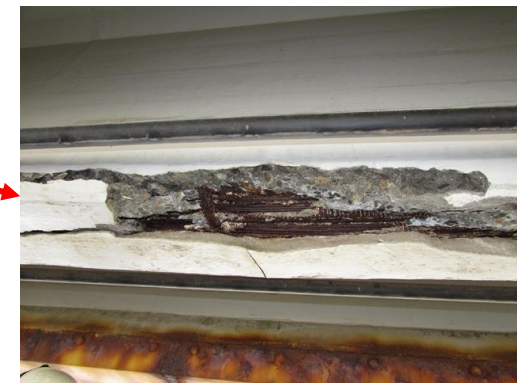
飛来塩分による塩害の損傷
