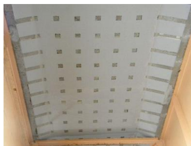
炭素繊維接着補強
