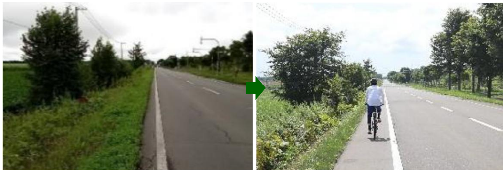
《自転車走行環境改善に向けた路肩拡幅》
