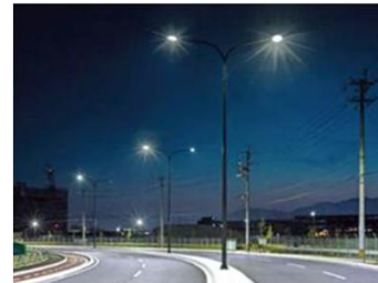
《LED道路照明》
