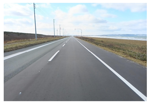
《矢羽根型路面表示の設置（上）、路肩の拡幅（下）》
