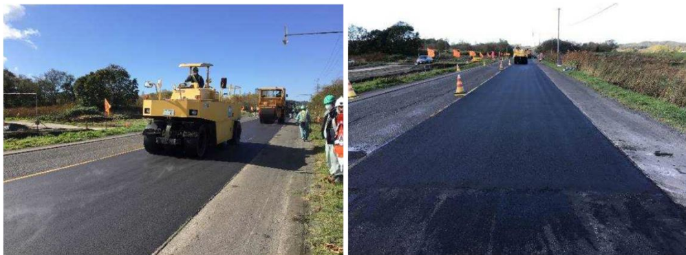
《低炭素アスファルト舗装施工例（一般国道40号天塩町雄信内舗装）》
