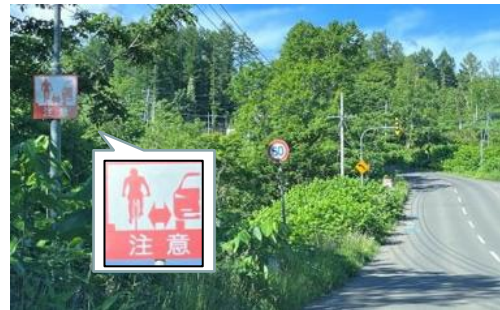
【道道343号】(2022年度整備)
