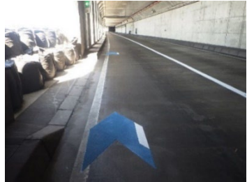
日方泊トンネル(増毛町)
