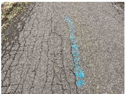
【分岐路面表示】 (2018年度整備)
