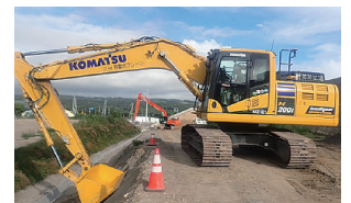
▲ICT 施工状況
