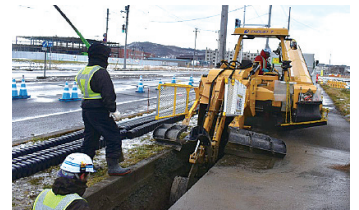
▲トレンチャー機械による掘削施工 (国道231号 留萌電線共同溝)
