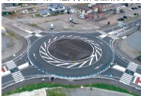
▲ラウンドアバウトの整備 (国道228号 上ノ国町)
