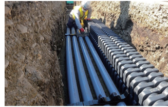
▲浅層埋設、角形多条電線管の施工 (国道5号 赤松街道電線共同溝)
