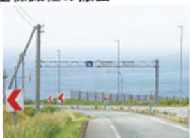
門型標識柱の撤去前
