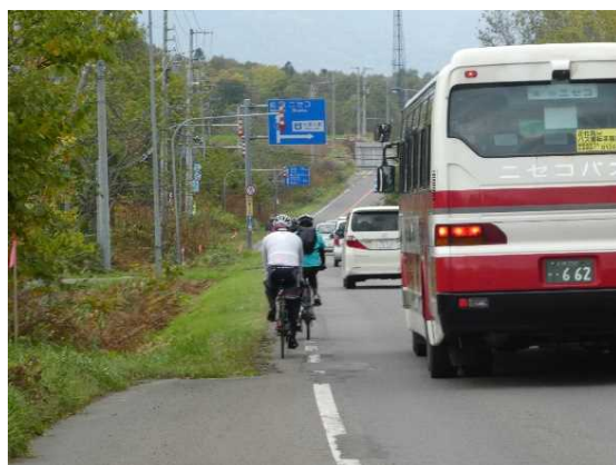
路肩狭小区間
