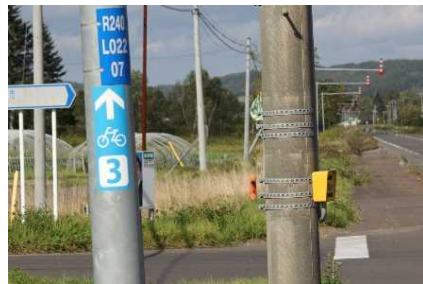
単路部(5km間隔)設置箇所
