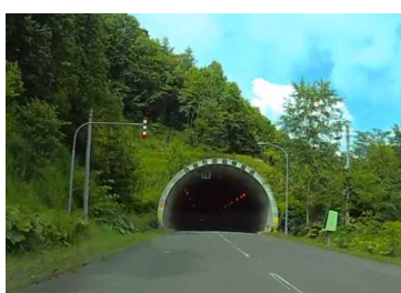
トンネル手前未設置箇所
