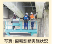
写真：直轄診断実施状況
