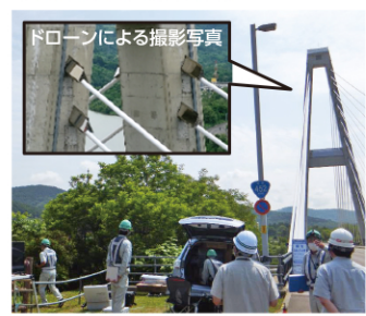
写真：ドローンの活用により高所での橋梁点検を効率的に実施
