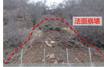
▲道路法面・盛土対策
