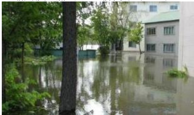
▼網走湖畔の観光ホテルの浸水状況 (H18.10)
