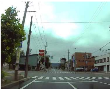
主要交差点部未設置箇所
