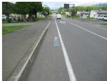
確認路面表示
