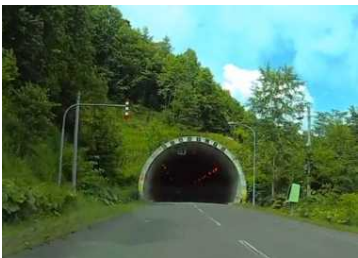
トンネル手前未設置箇所
