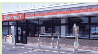
▲サイクルラック設置状況
