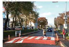
▲可搬式ハンブを用いたスムーズ横断歩道の整備（苫小牧市）
