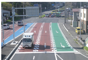
▲カラー舗装による車線の明確化（国道36号 登別市）
