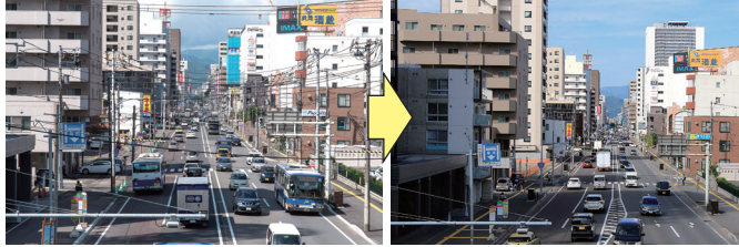
▲道路の防災性の向上（国道12号 札幌市）
