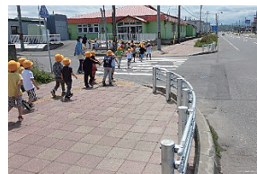
▲防護柵の整備による子供の安全な通行の確保（国道231号 留萌市）
