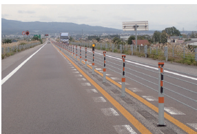
▲ワイヤロープによる正面衝突事故対策（函館・江差自動車道）
