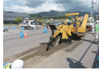
▲トレンチャー機械による試験施工（国道5号 赤松街道電線共同溝）
