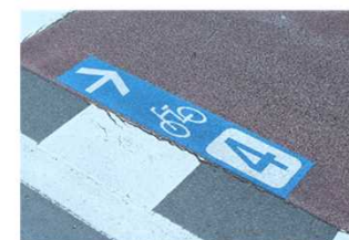
樹脂系すべり止め塗装の施工例（帯広市）
