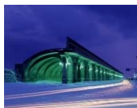
稚内港北防波堤ドーム
