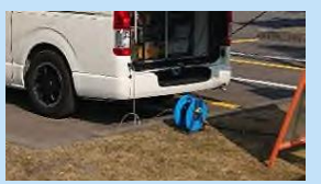
電源設備の使用風景
