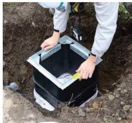
計測機器の設置
