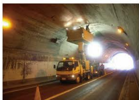
トンネル点検車による定期点検
