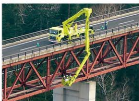
橋梁点検車による定期点検
