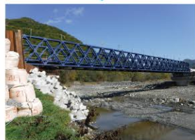
【仮橋架設完了】
