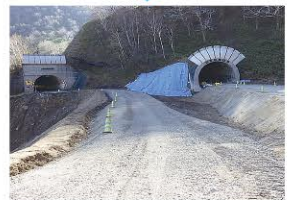
【工事用道路施工】
