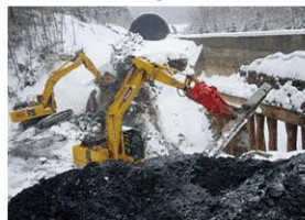
【覆道下部工撤去作業】
