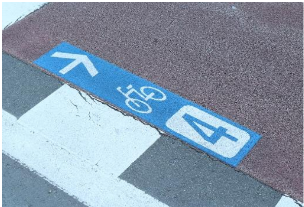
樹脂系すべり止め塗装の施工例（帯広市）
