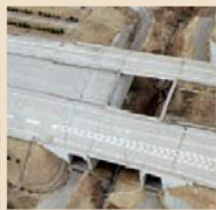
▲亀裂が生じ破壊された道央自動車道 平成12年4月20日 岡田弘氏撮影
