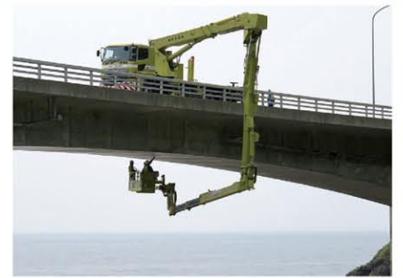
橋梁点検車による定期点検
