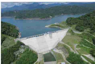
夕張シューパーダム
