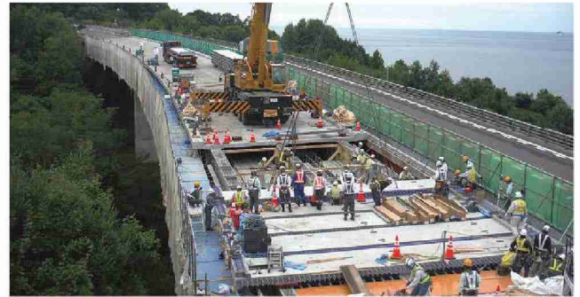
札幌道 大野橋 施工状況
