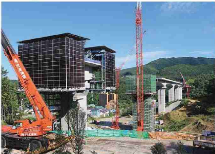
③ 天神橋(小樽JCT方面を望む)
