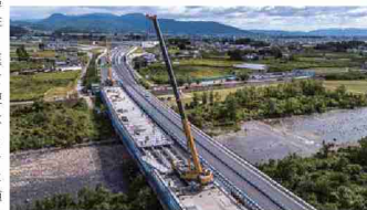
保阪改修工事の事例
