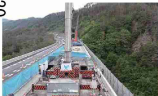
高速道路リニューアルプロジェクト
