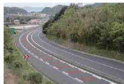
薄層舗装(青色の帯舗装)
