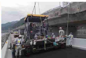
橋梁補修作業
