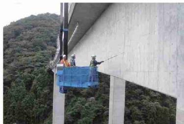
橋梁の打点点検
