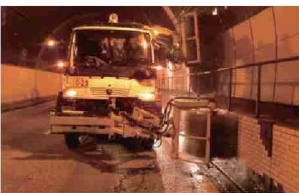
トンネルの定期清掃作業
