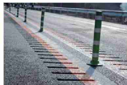
凹凸レーンマーク(暫定二車線区間)
