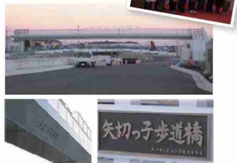
安切っ子歩道橋(松戸市下安切) 2018年10月撮影
