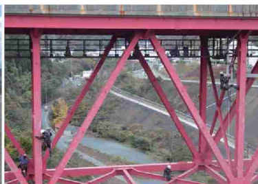
ロープアクセスによる橋梁点検
