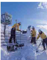
非常電話機の点検作業
