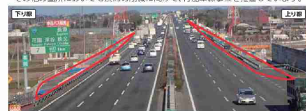
開通後 東松山IC付近の付加車線設置状況(2018年度完成予定)
