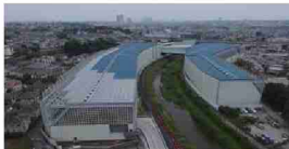
防音ハウスの設置状況
