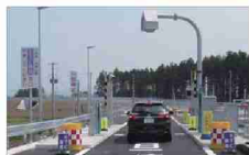
スマートインターチェンジ
