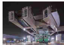
多軸台車による一括架設の施工状況
