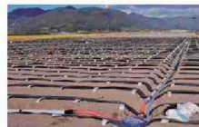
真空圧密工法の施工状況
