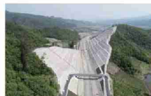
長大切土のり面(12段)の施工状況
