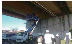
橋梁点検見学会
