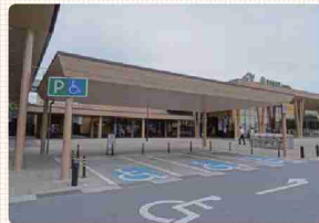
身体障がい者専用駐車スペース
