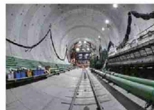
シールド工法による施工状況
