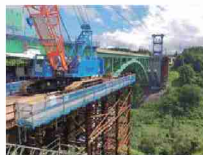
ケーブルレクシオン工法による施工状況
