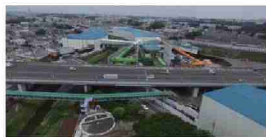
東名JCT付近の施工状況
