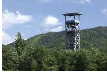
旧三井砂川炭鉱中央立坑 （上砂川町）
