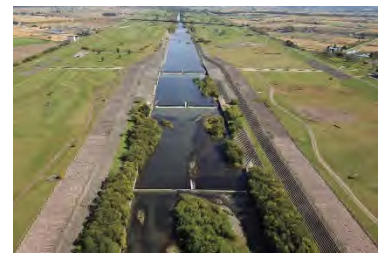
夕張川清幌床止（南幌町）
