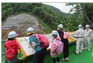
新桂沢＆三笠ぼんべつダムツアー 堤体建設予定地を見学
