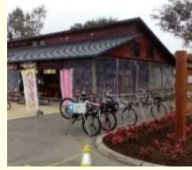
道の駅なかさつない (中札内村)【トカプチ400】
