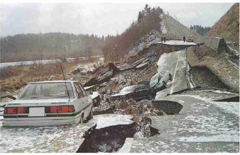
▼国道の被害状況(H5釧路沖地震)
