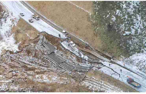
▼国道の被害状況(H5釧路沖地震)
