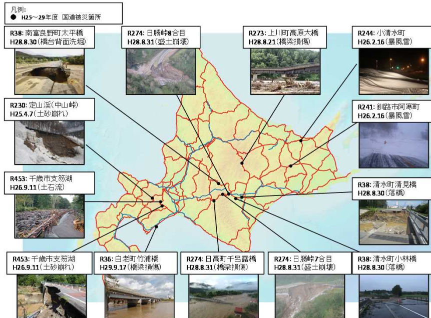
▼ 近年の道路被災の状況
