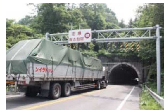
▼狭小トンネル区間における大型車通行状況 (R37クリヤトンネル)
