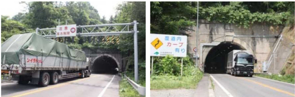
9 10 図 28 狭小トンネル区間における大型車通行状況（R37 クリヤトンネル）
