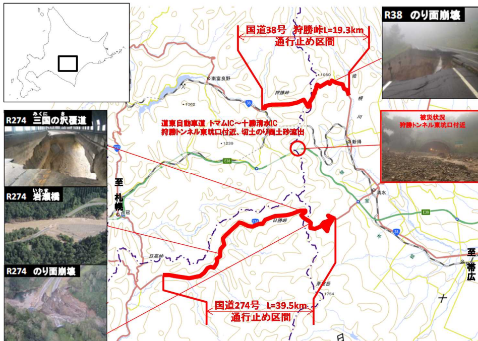
10 11 図 22 平成 28 年台風 10 号による道路被害状況
