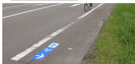
■案内用路面表示の設置状況 (トカプチ400 士幌町 国道241号)
