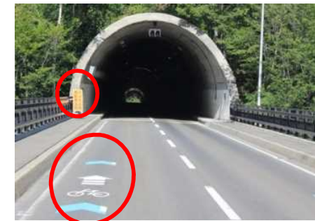
■ トンネルの入口手前における路面表示 (トカプチ400ルート 上士幌町 国道273号)
