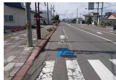
■交差点における路面表示 (トカプチ400 中札内村 国道236号)
