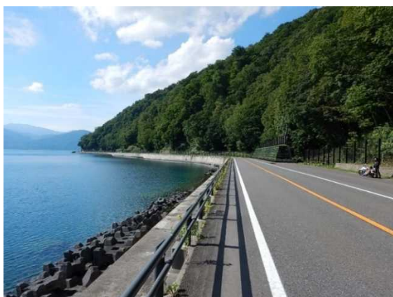
区画線補修 支笏洞爺ニセコルート(洞爺湖エリア)
