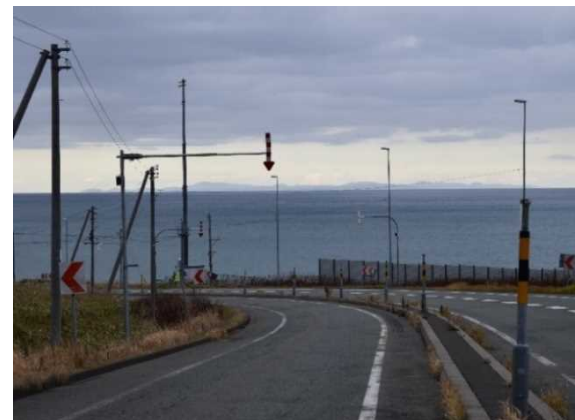
門型標識柱の撤去 宗谷シーニックバイウェイルート
